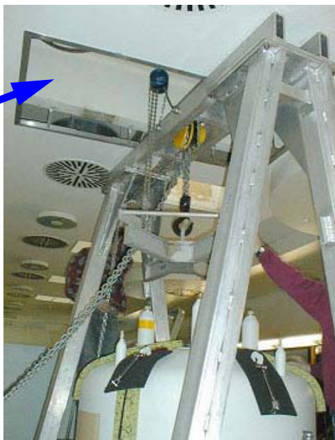
Figura 4.2. Una caja de falso techo (incluyendo la plataforma elevadora usada para la instalación)
