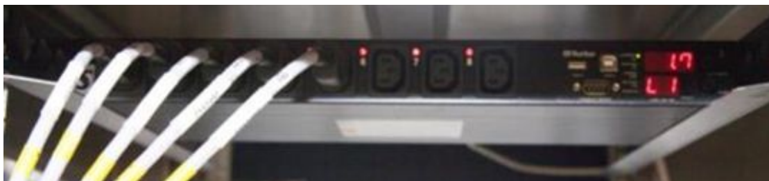
Rysunek 2.3: Rozdzielnica PDU
