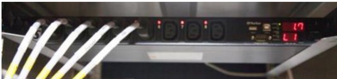
Figura 2.3: A unidade de distribuição de alimentação
