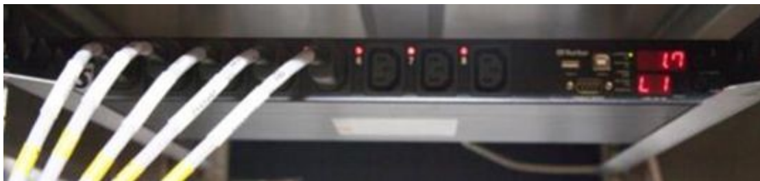
Рисунок 2.3: Блок управления электропитанием
